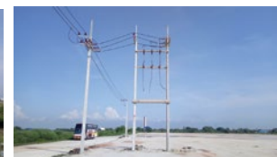
建設工場の受電設備を整備して、引き渡し
