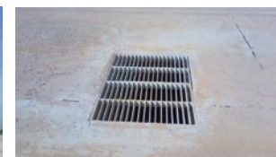
地中埋設給水管・排水管の敷設
