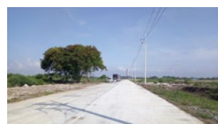
コンクリート道路を拡張し、電線も補充
